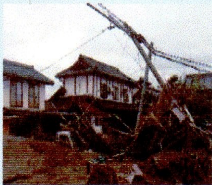
令和元年東日本台風後の 長沼地区の様子
